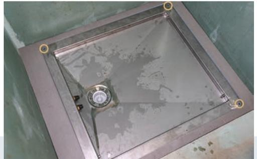
**Achtung:** Bleibt alles dicht, verschraube an den Befestigungsbohrungen in den Ecken die Wanne.
